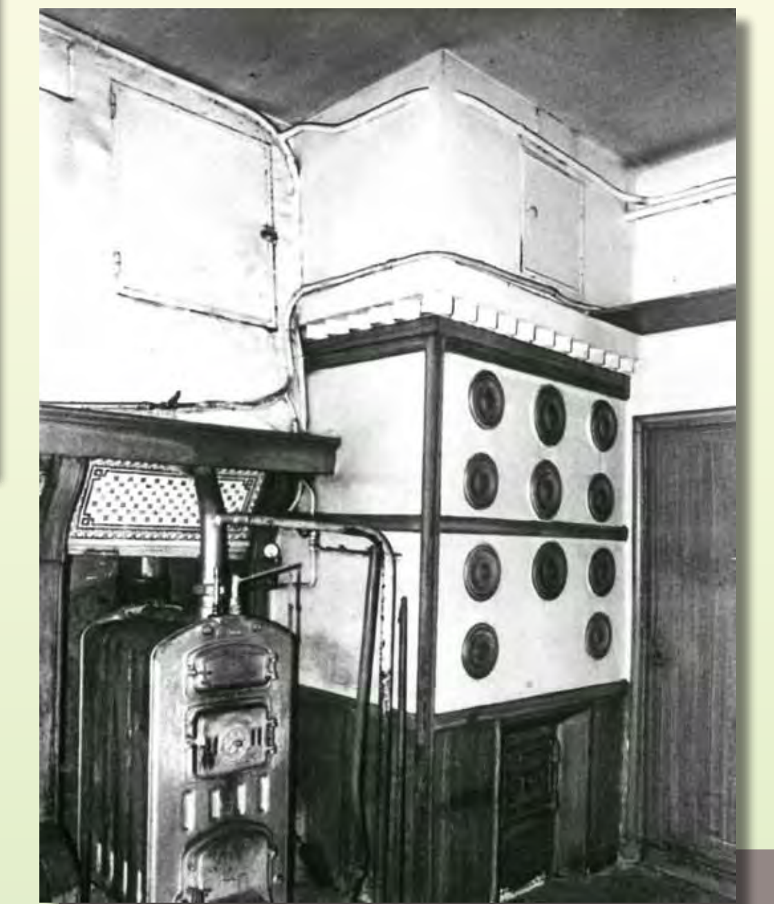
Un des deux calorifères du Val Ombreux
