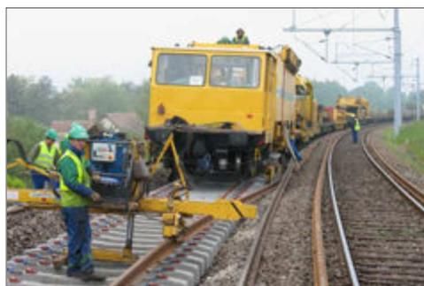
**Longs Rails soudés sur traverses béton**
