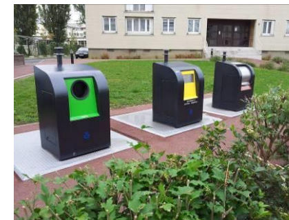
Collecte par bornes enterrées
