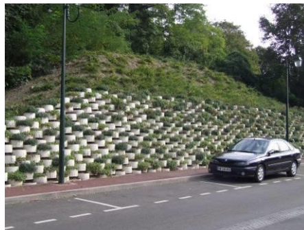
Mur de soutènement végétalisé
